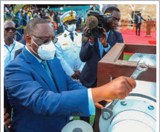
USINE DE DESSALEMENT D'EAU DE MER
